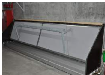
Twin-verwarmingsbuizen onder de regelbare luchtinlaatklep
