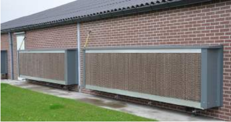
Pad koeling voor de luchtinlaat
